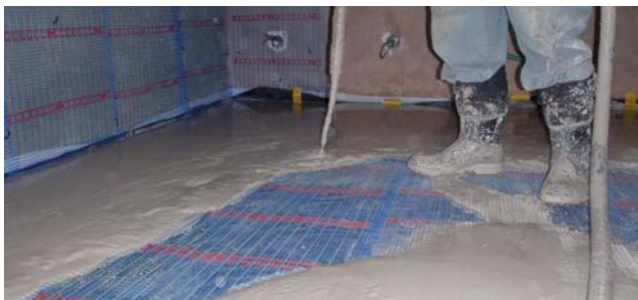
Zalievanie podlahového vykurovania s kapilárnymi rohožami
